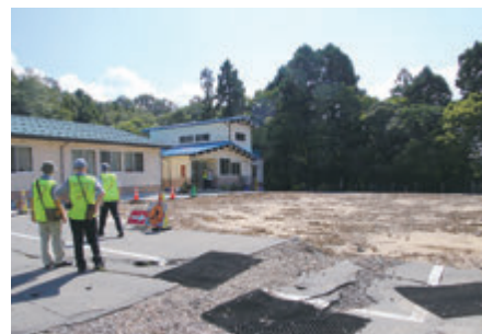
解体され更地となった教会跡
